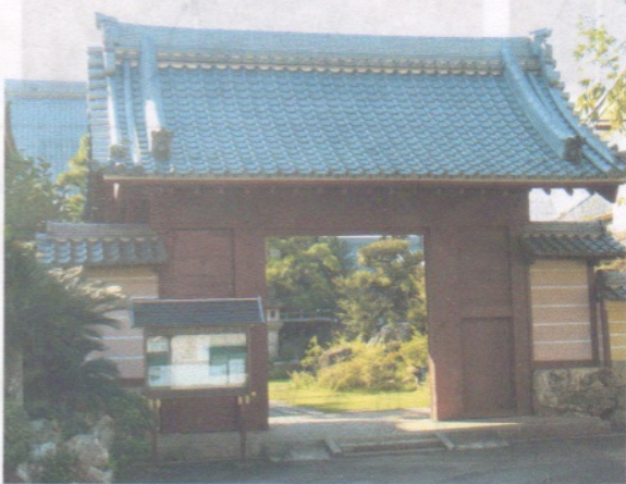
上宮寺の山門 たびたび修築され、近年、屋根が葺き替えられ、木造部は朱色（紅殻）に塗られています。
